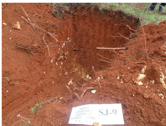
Fotografija 10: Sondažna jama SJ-9
